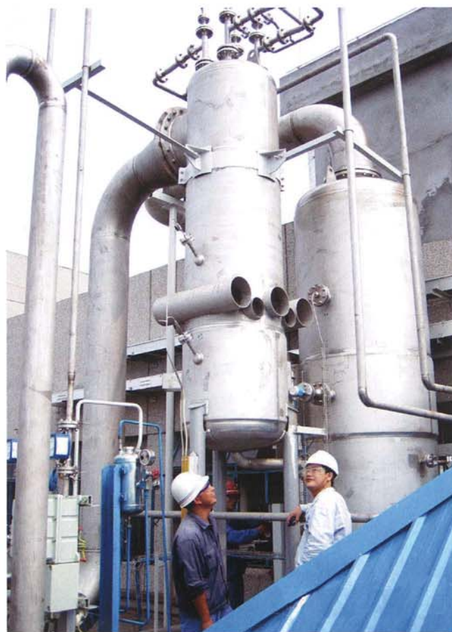
化学プラントにおける細塵とSO 2 の分離
